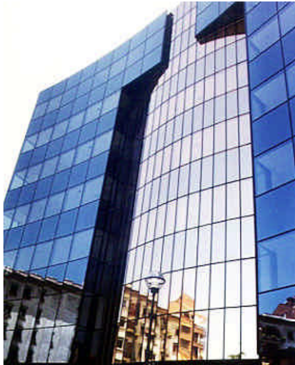
Fig. 9.15. Muro cortina con perfiles no vista
