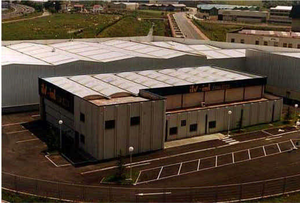
Fig. 9.6. Detalle de fachada de paneles nervados de hormigón prefabricado
