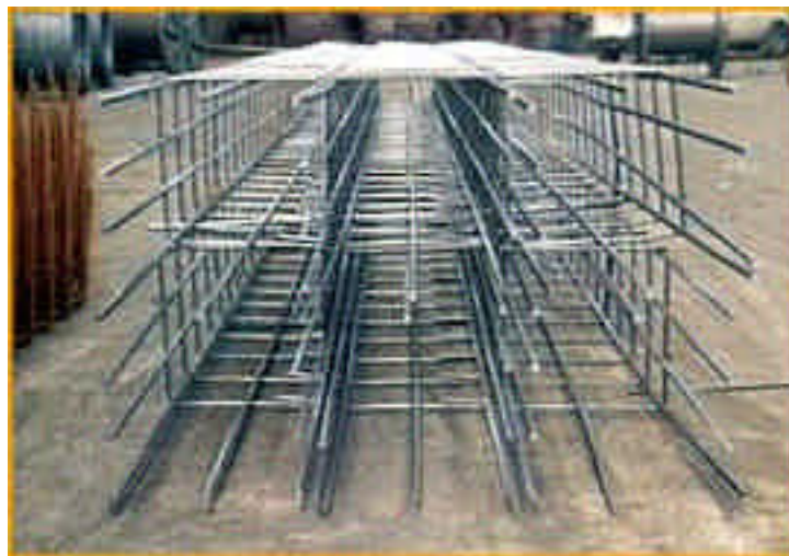
Fig. 10.6. Armaduras para hormigón armado
