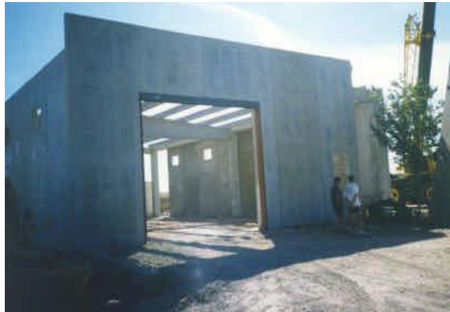
Fig. 9.4. Fachada de paneles planos de hormigón prefabricado
