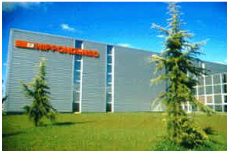
Fig. 9.12. Fachada de panel metálico sandwich
