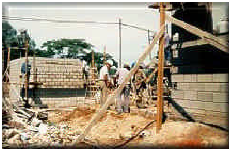
Fig. 10.4. Paredes de bloque de hormigón
