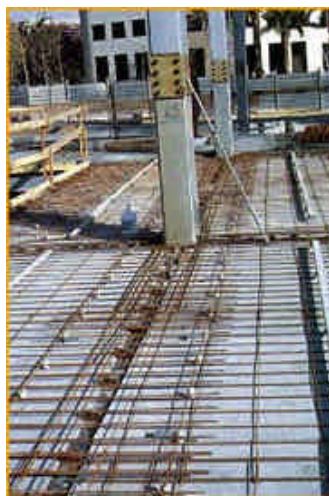
Fig. 10.5. Estructura de hormigón armado
