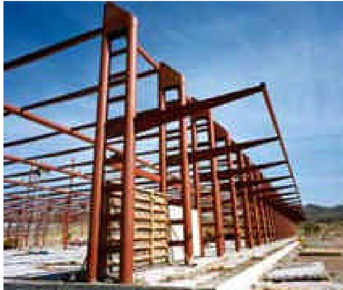
Fig. 10.9. Nave industrial con estructura metálica (perfiles con secciones pequeñas)
