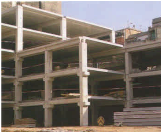
Fig. 10.8. Oficinas con estructura prefabricada
