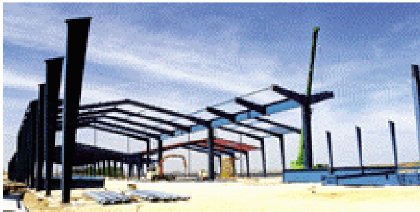
Fig. 10.11. Ejemplo estructura metálica inacabada
