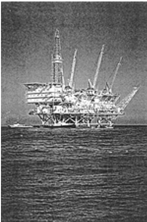
Figura 12 La torre de perforación llega a tener alturas considerables, para permitir la utilización de barrenos de la máxima longitud posible durante las operaciones y para facilitar la maniobrabilidad.
